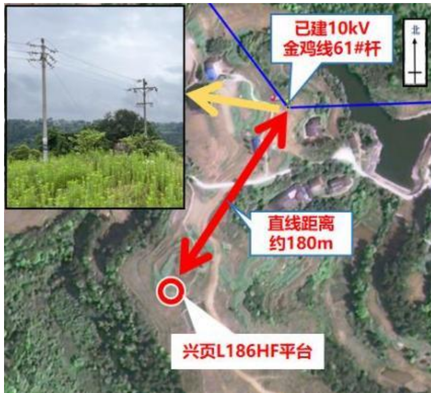
图 2.3-3 兴页L186 平台周边可依托电力线现场照片
